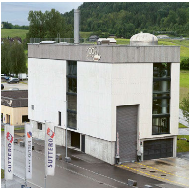
Die moderne Holzsnitzelheizung versorgt die Betriebsgebäude der Ernst Sutter AG am Hauptsitz in Gossau mit CO 2 -neutraler Wärme.
