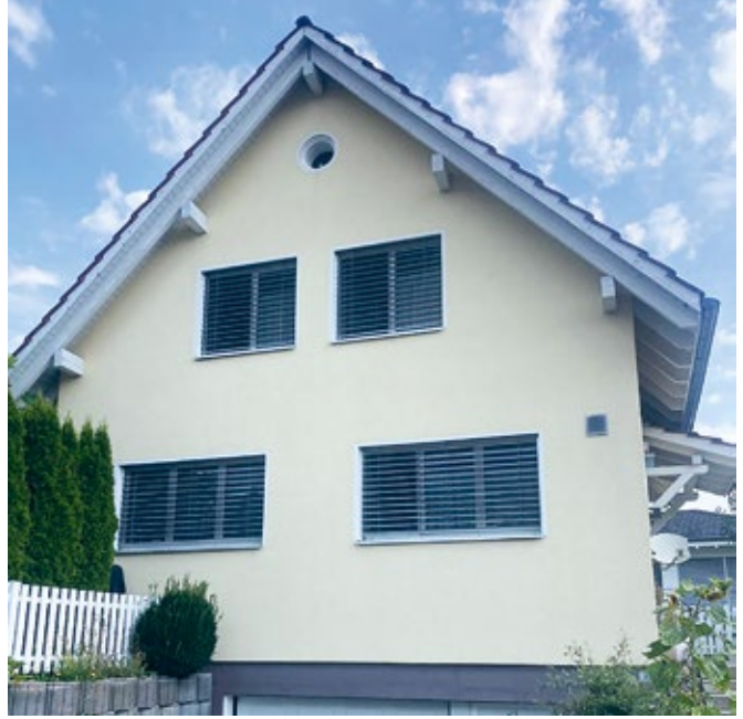
Fassade ca. ein Jahr später
