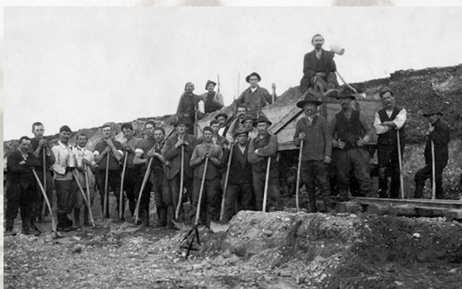
Arbeiter beim Bau des Diepoldsauer Rheindurchstichs
