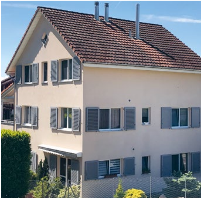
Ziegeldach in Felben vorher
