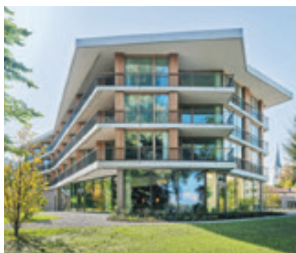
Der Neubau hebt die Standards für die Rehabilitation auf ein neues Niveau.
